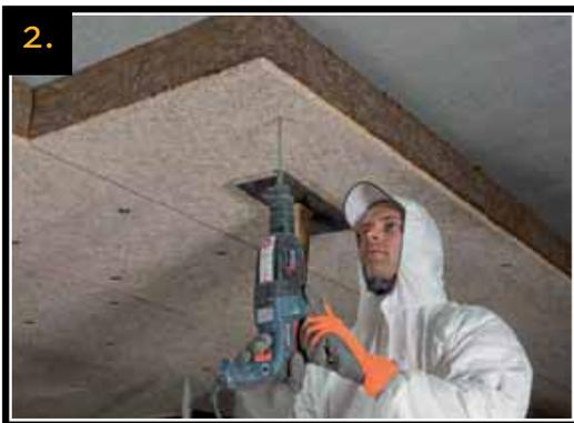
Retirez le foret et placez l'accessoire de montage spécialement prévu à cet effet sur la perceuse. La cheville à frapper pleine peut ainsi être installée en toute simplicité et de façon parfaitement droite.
