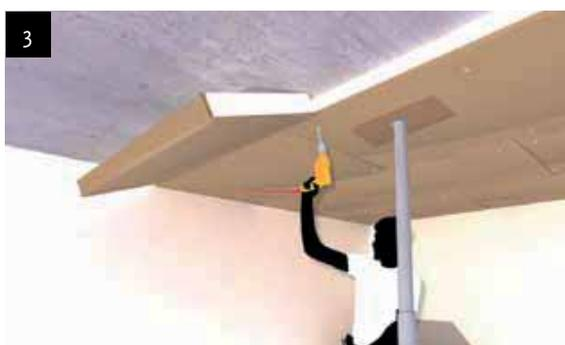
Forez le panneau dans le béton. Enfoncez (en donnant des coups) ou vissez la cheville à travers le trou foré, dans le béton.
