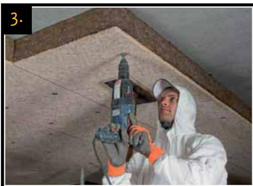
Faites passer la cheville à travers le panneau isolant dans le trou foré, puis basculez du mode rotation de la perceuse au mode burinage. Enfoncez la cheville dans le béton au moyen de la perceuse à percussion.
