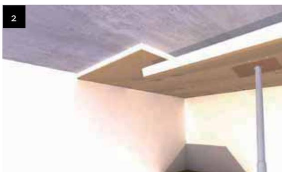
Les panneaux d'isolation peuvent être mis en place directement contre la construction en béton par fixation mécanique, au moyen de chevilles à frapper ou de vis auto-taraudeuses. (Voir le chapitre Trucs et astuces pour la méthode de fixation correcte).
