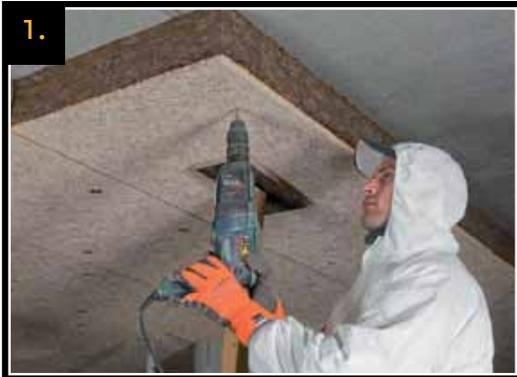
Apposez le panneau de laine de bois ou isolant contre le béton. À l'aide d'une perceuse à percussion, percez un trou de forage dans le béton (6,5 mm) à travers le panneau, en respectant les consignes de mise en œuvre des chevilles.
