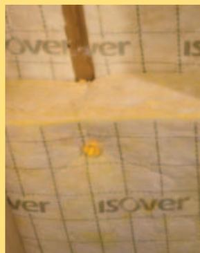
Mise en place de la 2<sup>de</sup> couche d'isolant Isoconfort
