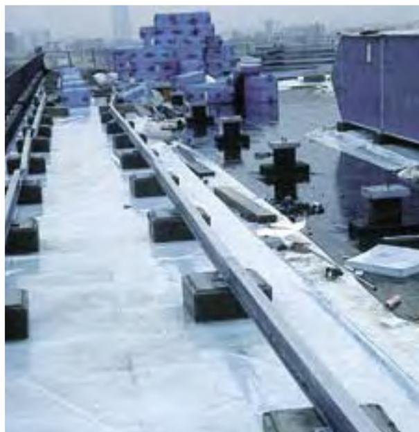
Euroatrium - Saint Ouen 93 - 5000 m<sup>2</sup> de toitures à retenue temporaire des eaux pluviales avec le procédé "ROOFMATE minK Système" : chemin de nacelles et massifs pour ancrage des équipements techniques (antennes, ventilation, ...)
