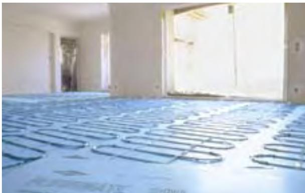
Plancher électrique sous Avis Technique
