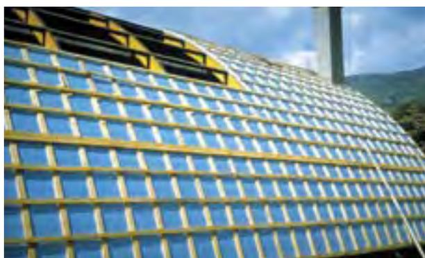
Gymnase d'Aiguebelle (73) - Rénovation avec Sarking, compatible avec toiture courbe
