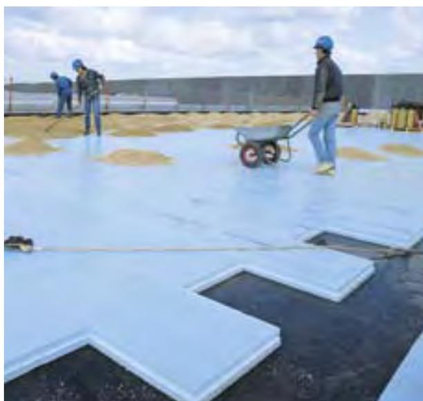
Isolation inversée avec ROOFMATE SL : mise en œuvre aisée, compatible avec les conditions réelles de chantier
