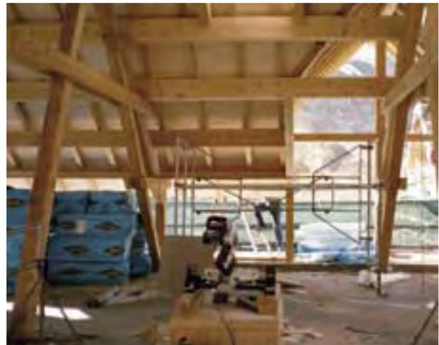
Charpente apparente avec ROOFMATE Sarking-Montagne
