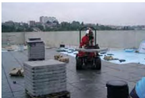
La résistance mécanique des isolants STYROFOAM pour isolation inversée permet la mise en œuvre de techniques innovantes.
