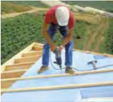
Isolation par l'extérieur des toitures inclinées selon le procédé "Sarking" (sous Avis Technique)
