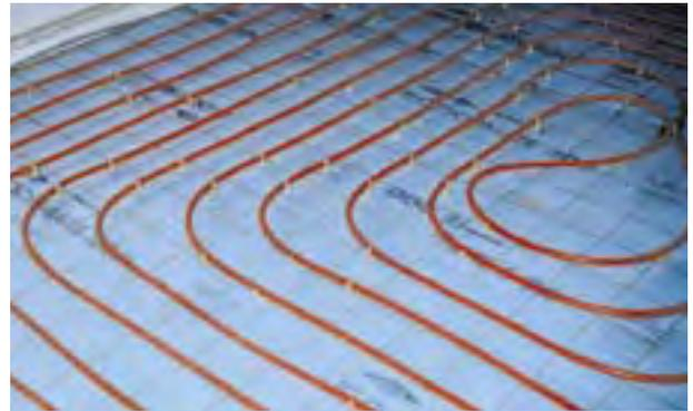
Plancher chauffant hydraulique à tubes en matériau de synthèse.
