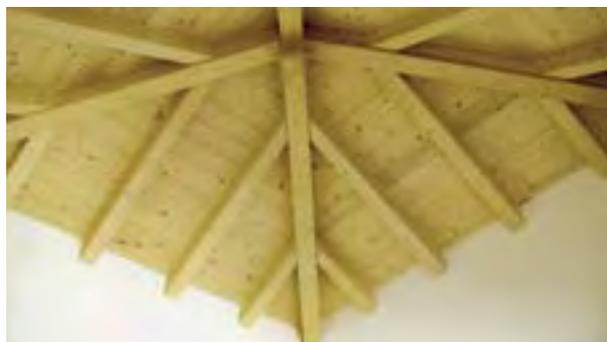
Charpente apparente avec procédé "Sarking"
