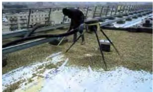
Euroatrium - Saint Ouen - 93 - 5000 m<sup>2</sup> de toitures à retenue temporaire des eaux pluviales avec procédé "ROOFMATE minK Système" : chemin de nacelles et massifs pour ancrage des équipements techniques (antennes, ventilation, ...)
